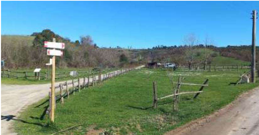
Recinzione da ripristinare.
