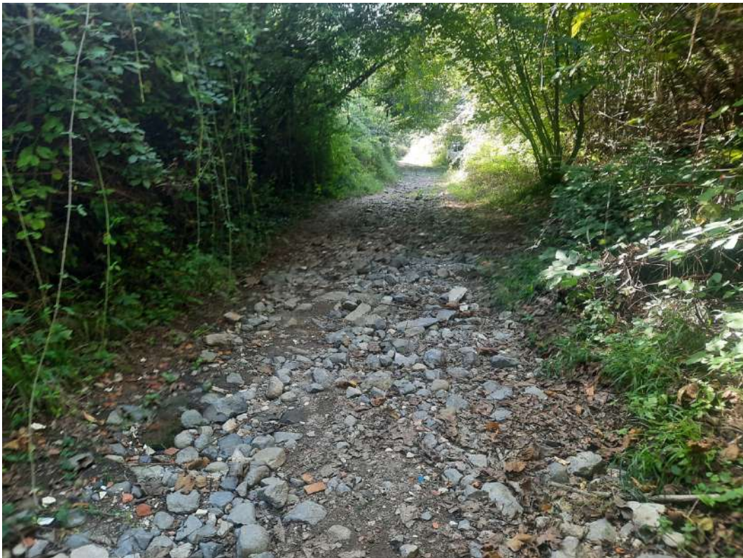
Tratto della viabilità oggetto di manutenzione del fondo.
